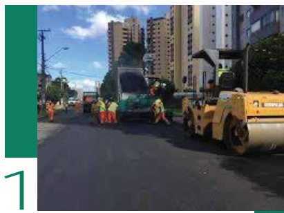
1 RECAPEAMENTO ASFÁLTICO
